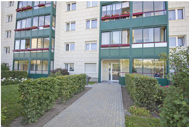
Eingangsbereich Straße barrierefrei
