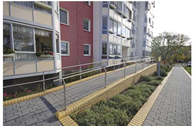
Rampe Eingang hinten
