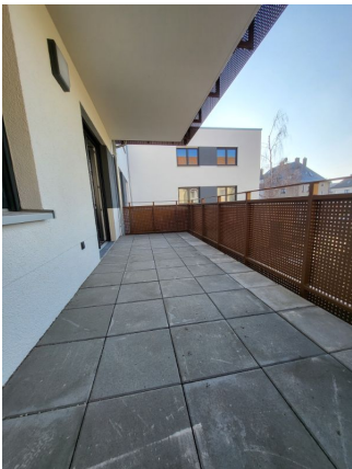
Beispiel Balkon / Terrasse
