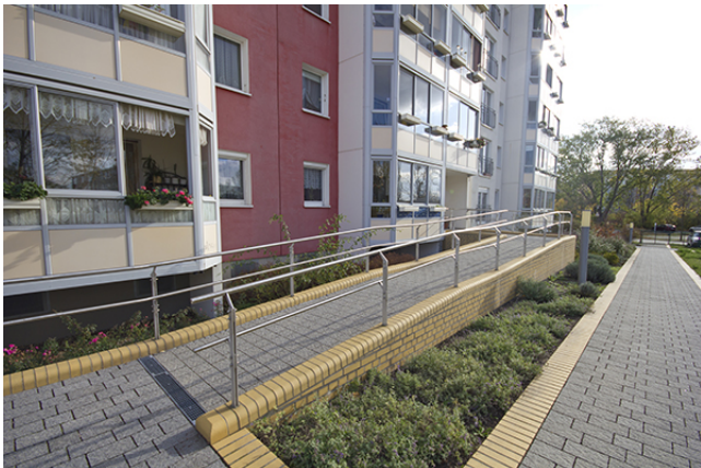
Rampe Eingang hinten
